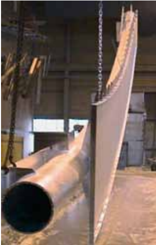
Dicke der Gehwegplatte ist dem Tragrohr angepasst worden.
