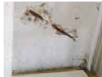
Ungenügende Überdeckung des Bewehrungsstahls bewirkt eine Abplatzung des Betons.
