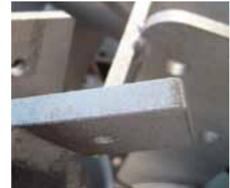
Strahlen: Massnahme zur Reduzierung von Haftungsproblemen durch Entfernen scharfer Kanten und gefügeveränderter Oberflächen.
